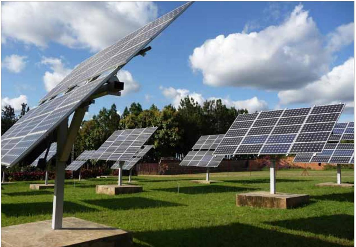
panneaux en direction du soleil ; ils peuvent être ajustés manuellement pour protéger les panneaux en cas de forte pluie ou de vent.
